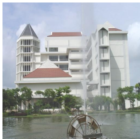
ภาพอาคารศูนย์คอมพิวเตอร์ปัจจุบัน
